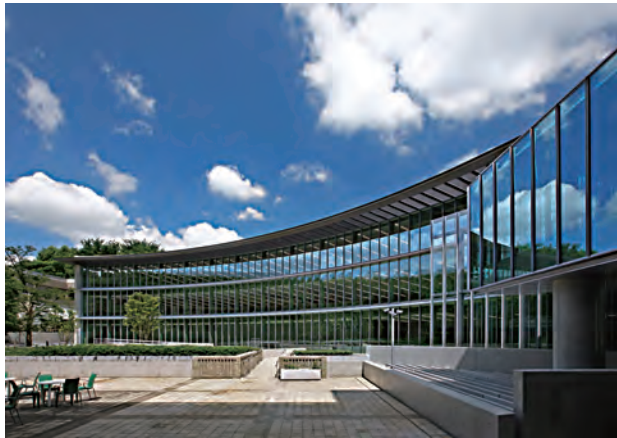
新設されたアーチ棟
