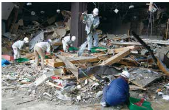
陸前高田市立博物館での救出作業。引き波によって博物館には住宅や車など大量の瓦礫が流入し、床には1メートル以上の砂が堆積していたため、資料の救出は困難を極めた
