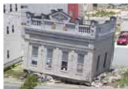
男山本店店舗被災状況
