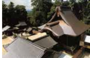
修復された「高野神社本殿」 (岡山県津山市)
