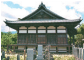
修復された「大英寺本堂」(長野県長野市)
