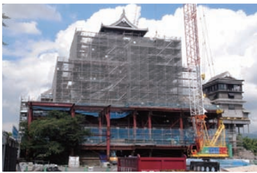
天守閣工事、東より。地震で落下した二基の鯨幹も新たに取り付けられている(平成30年7月現在) 写真・熊本城総合事務所提供(上、下)
