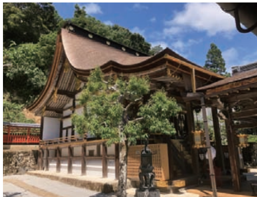
檜皮が葺替えられた本殿
