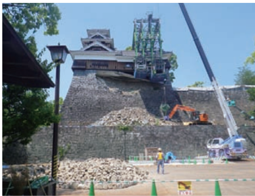
崩落石材を無人重機で回収。南より(平成29年5月)
