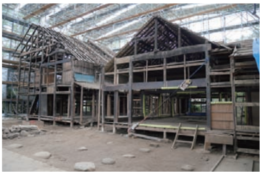
江藤家住宅解体復旧の現状
