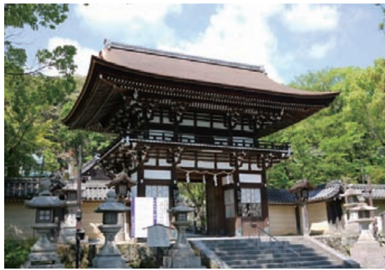
本殿に先立ち改修された楼門
