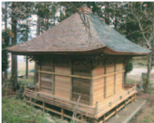
宮城県・天雄寺観音堂 (修復後)
